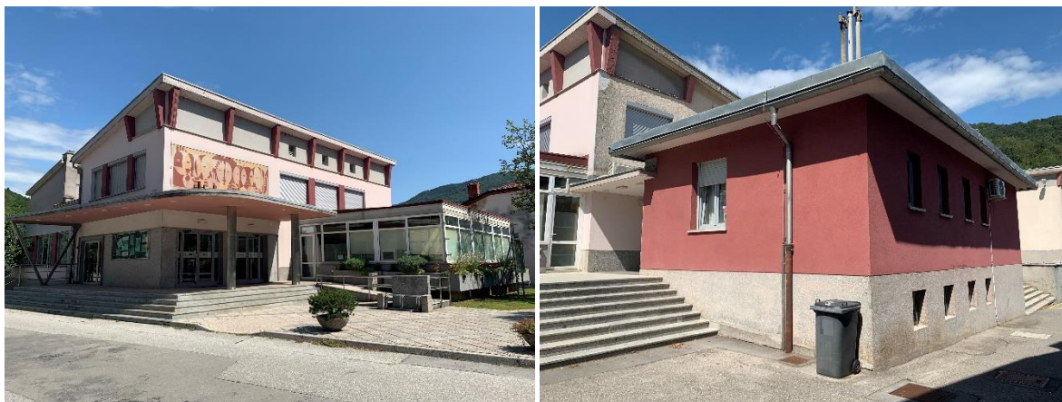
Slika 5: Frontalna fasada Kulturnega doma Deskle (levo), hišniško stanovanje (desno)
