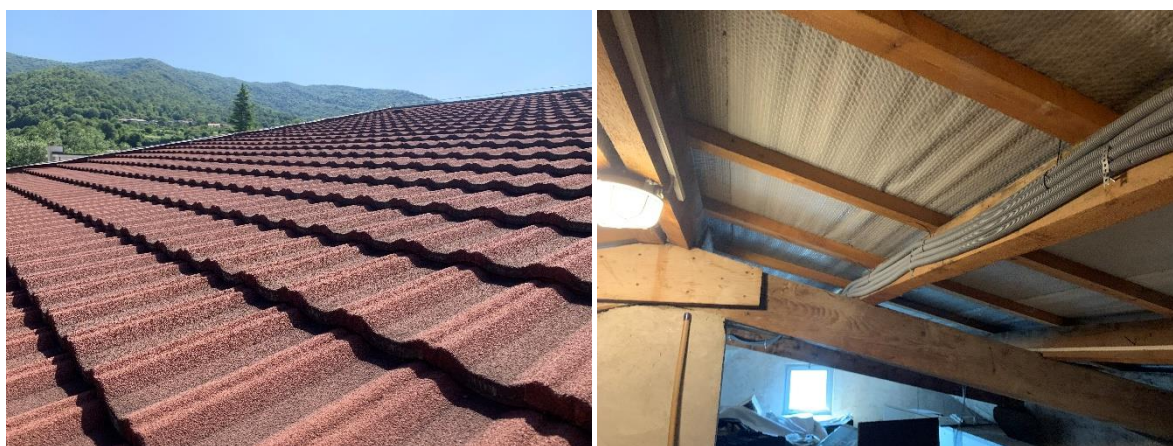
Slika 7: Streha nad glavnim odrom (levo), strešna konstrukcija nad knjižnico (desno)
