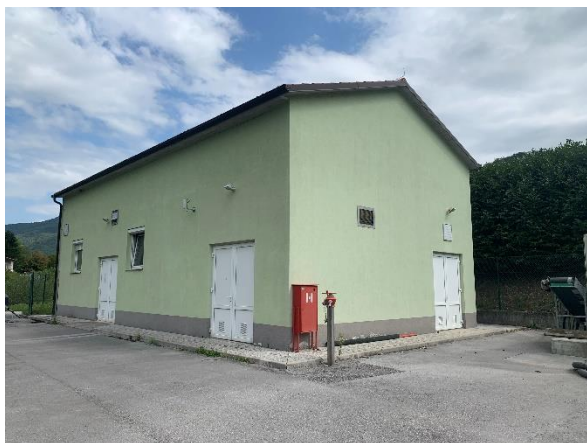
Slika 23: Čistilna naprava Deskle
