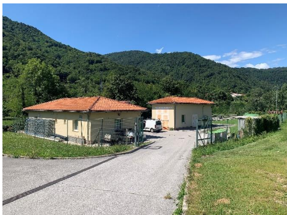
Slika 20: Čistilna naprava Kanal
