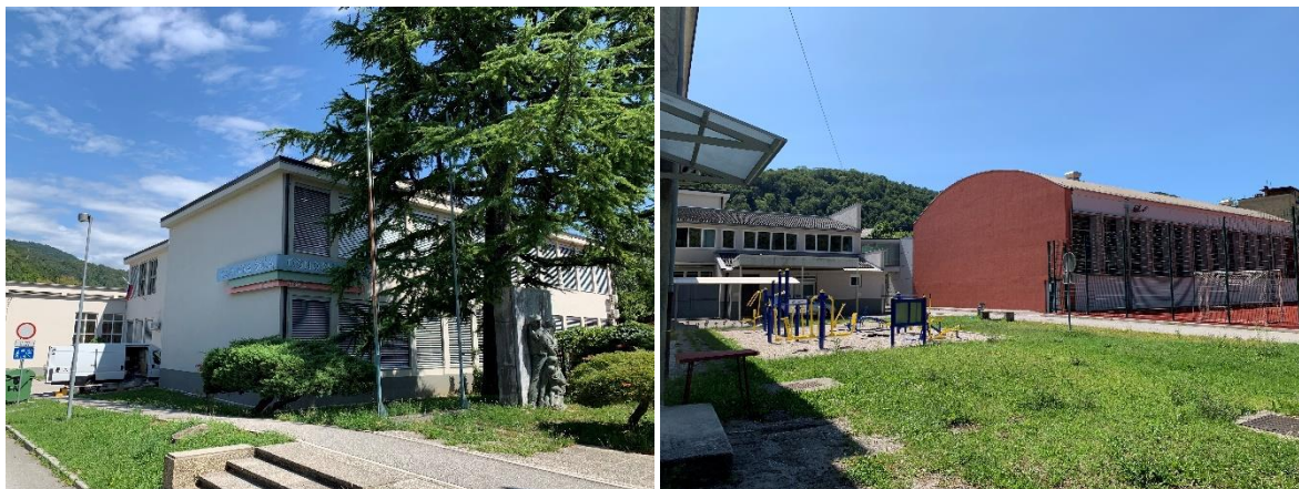
Slika 9: Osnovna šola Deskle (levo), športna dvorana Deskle (desno)
