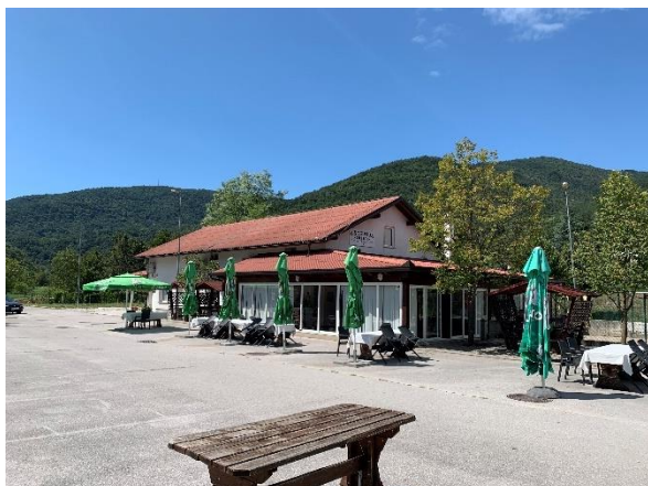
Slika 14: Stavba v Športnem parku Ložice
