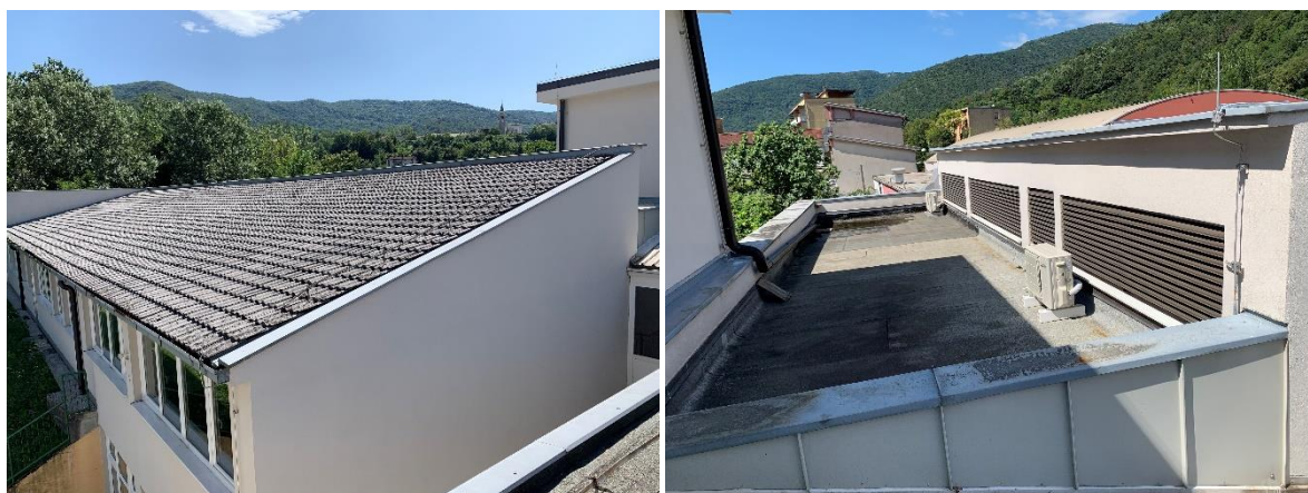
Slika 12: Poševna streha učilnic v V traktu šole (levo), ravna streha nad povezovalnim hodnikom v Z traktu (desno)
