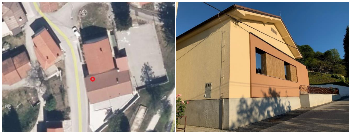
Slika 18: Lokacija elektro omare – Kulturni dom Lig (levo), elektro omara na fasadi (desno)
