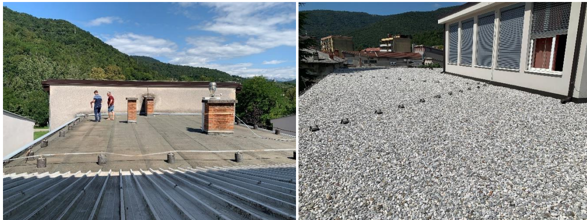
Slika 11: Ravna streha nad učilnico (levo), ravna streha nad 1. nadstropjem ob knjižnici (desno)
