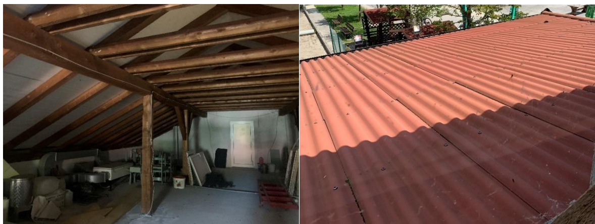
Slika 16: Ostrešje stavbe (levo), streha nadstreška na SV strani stavbe (desno)
