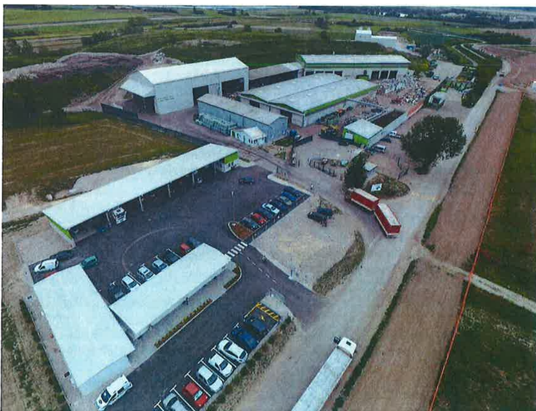
Slika 1: Center za ravnanje z odpadki Spodnji Stari Grad
