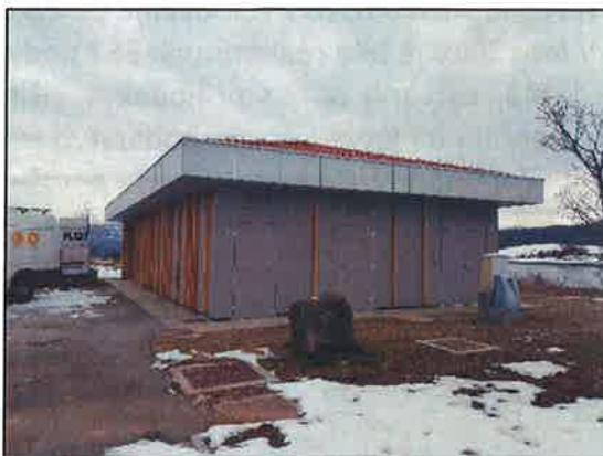
Zahodna in severna fasada
