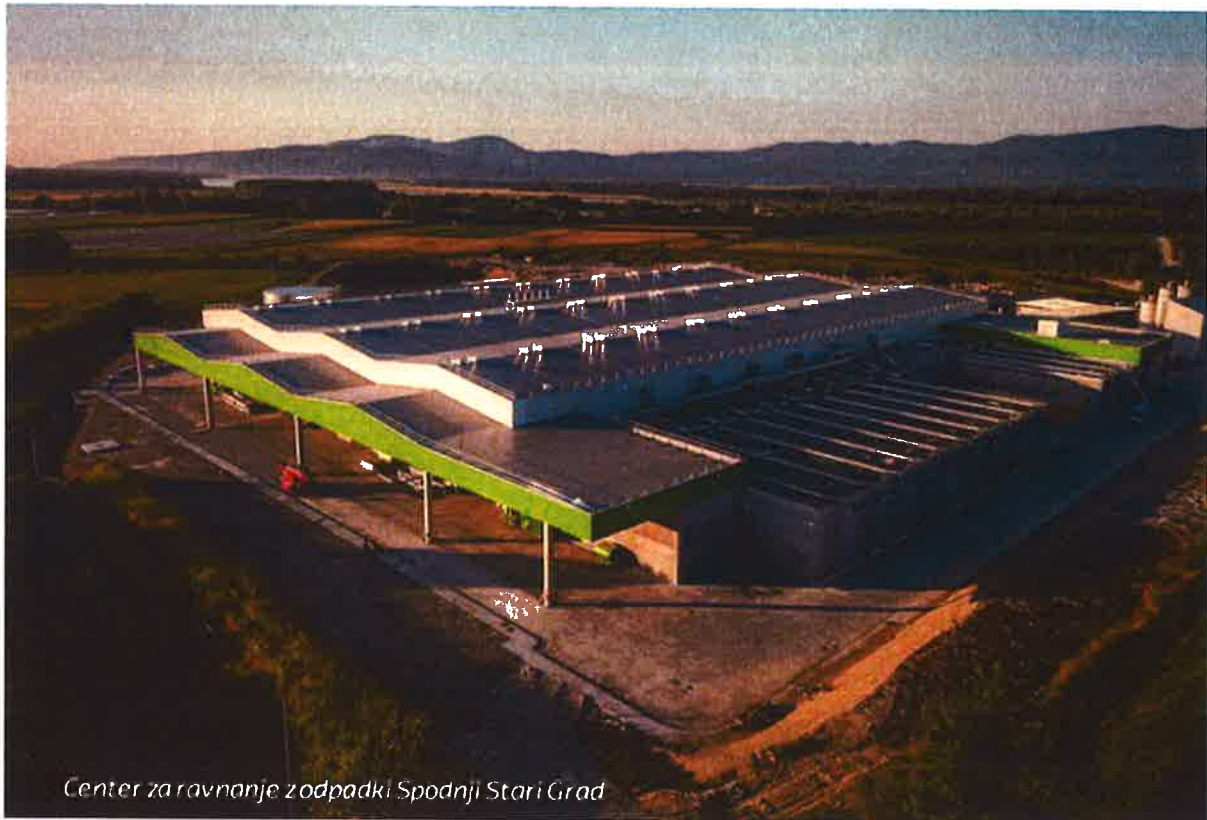
Slika 1: Center za ravnanje z odpadki Spodnji Stari Grad (novozgrajeni proizvodni objekt)
