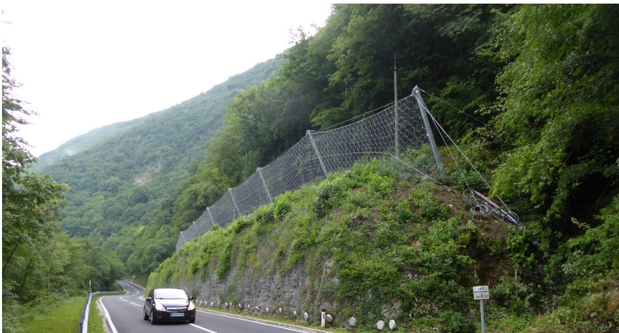
FOTO 4: Zavarovanje ceste s podajno lovilnim sistemom (cesta Solkan – Most na Soči)
