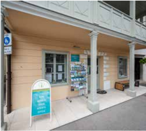
TIC Kanal. Foto: Damjan Simčič, ZOSO
