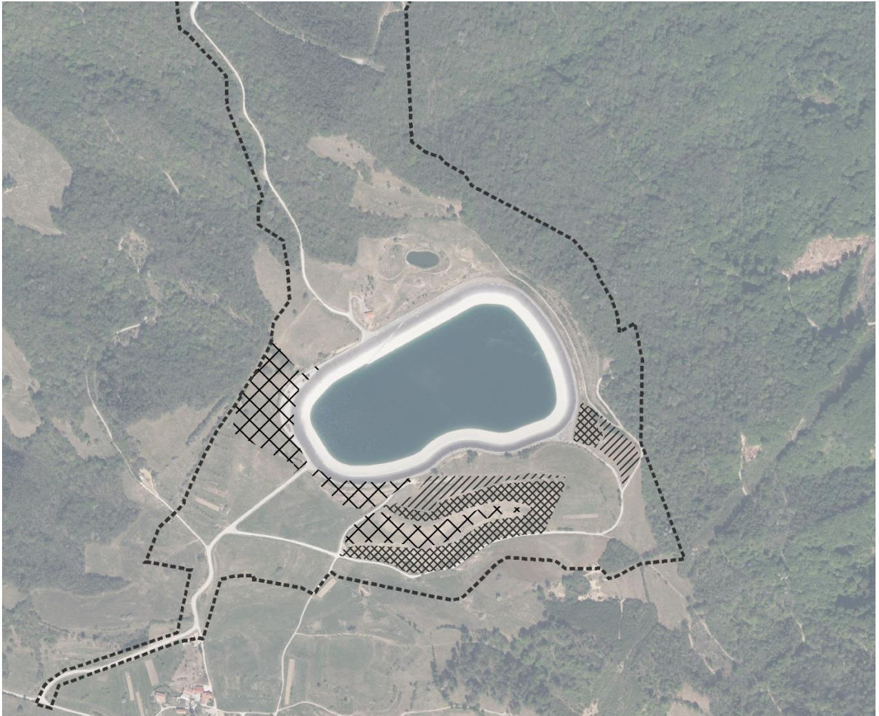
Slika 8: Faze izvedbe sončne elektrarne
