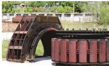
Demontiran generator 1, bodo v SENG-u restavrirali in razstavili kot spomenik tehniške dediščine.
