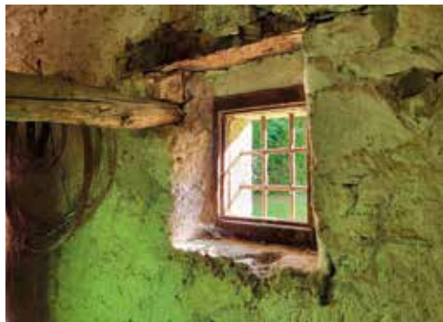
Pogled na zgradbo od blizu.
