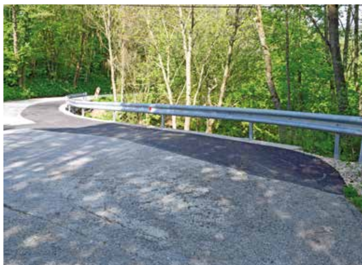
KOSTANJEVICA (sanacija podpornega zidu)
