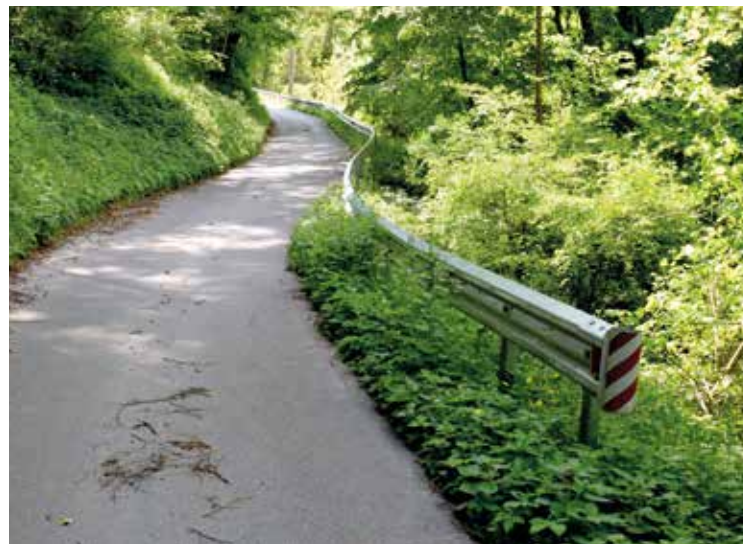
DOBLAR (postavitev varnostne ograje)
