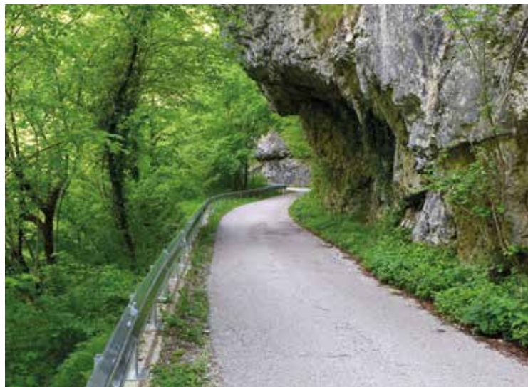
DOBLAR (postavitev varnostne ograje)
