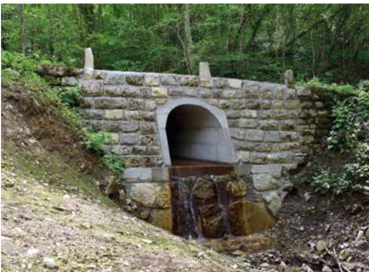
PODKLANEC (sanacija propusta)
