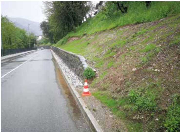
KANAL (čiščenje in ureditev brežine z bermo)
