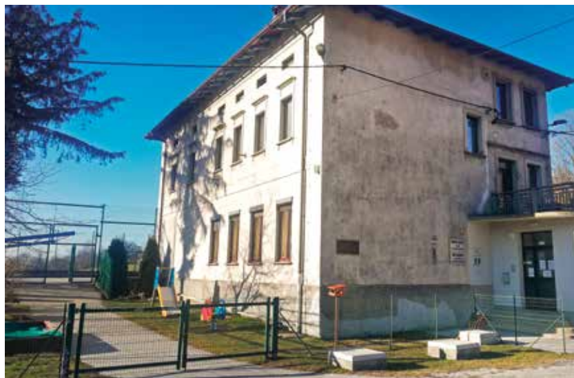
Podružnična šola Kal nad Kanalom
