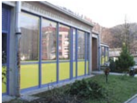
Obnovljeno pročelje vrtca v Desklah.
