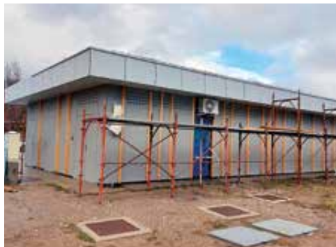
Prenova objekta na Kanalskem Vrhu
