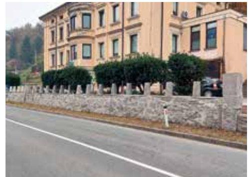
Sanacija kamnitega zida ZD Kanal
