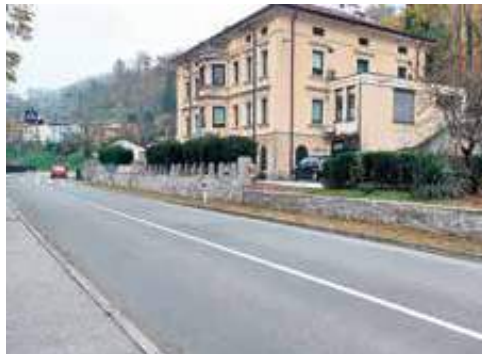
Sanacija kamnitega zida ZD Kanal
