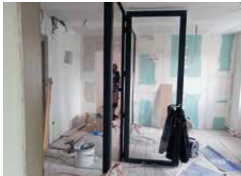
Obnova nadstropja v Ticu
