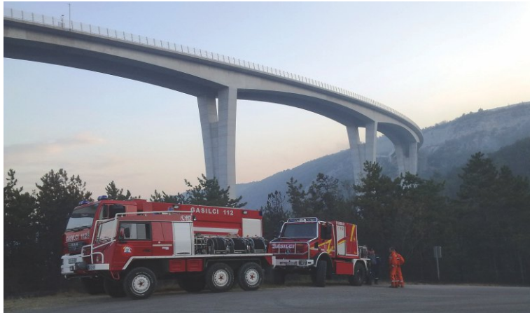
Nočna straža PGD Kanal pod viaduktom Črni Kal
