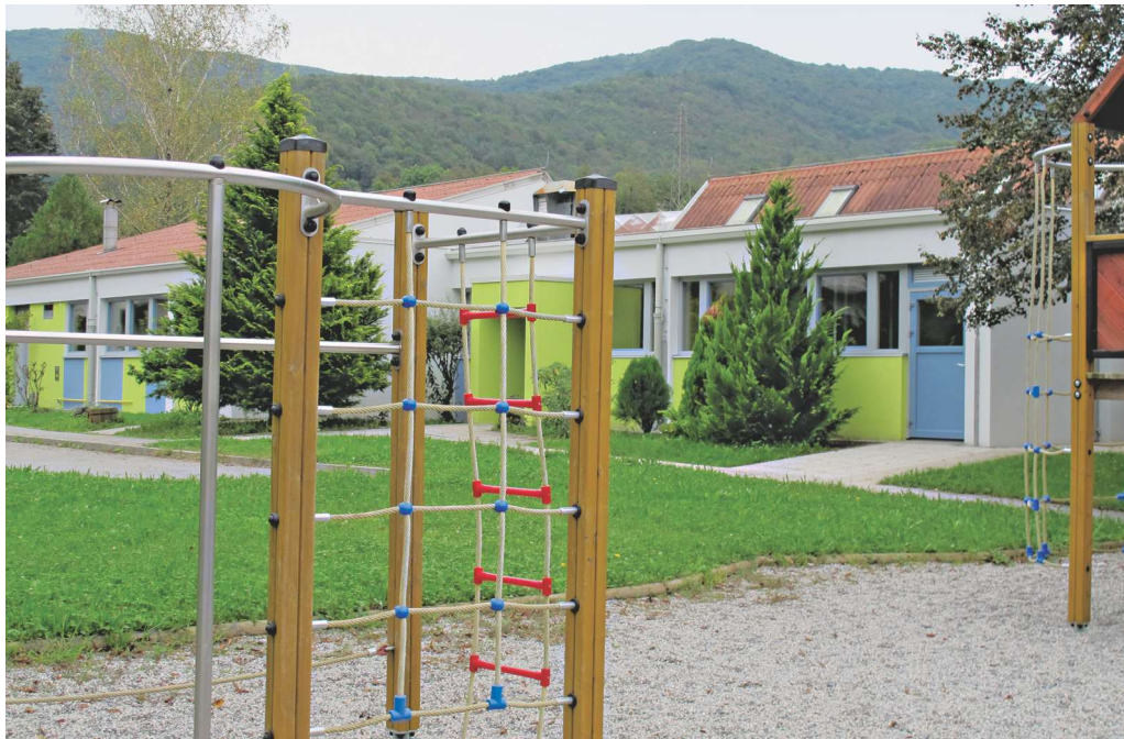
Vrtec Deskle v novi energetska varčni preobleki
