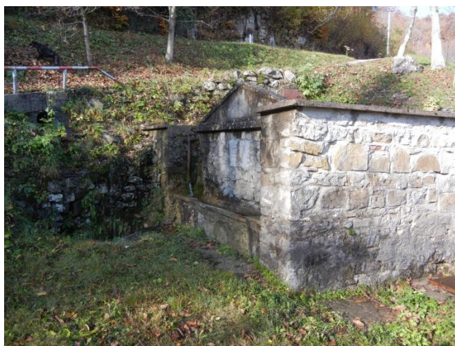
Slika1: Obstoječi rezervoar Čolnica
