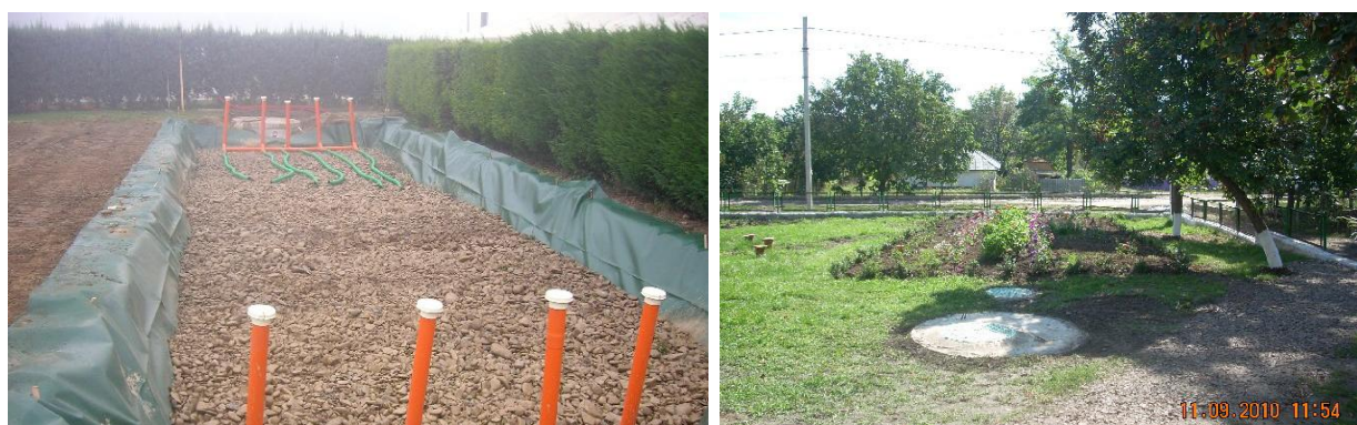
Slika 3 in 4 prikazujeta namestitve različnih materialov, kateri imajo tudi različne granulacije in končen zgled RČN
