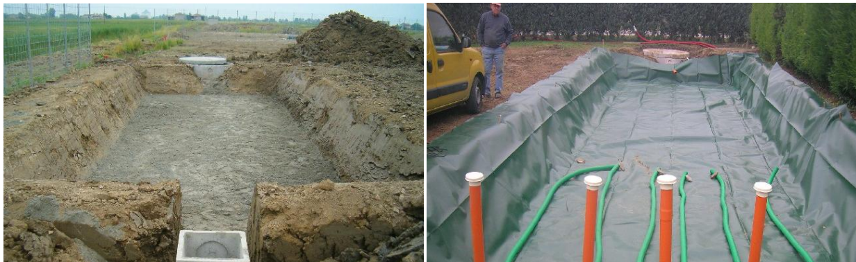
Slika 1 in 2 prikazujeta izkop in postavitev vodotesnega platna
