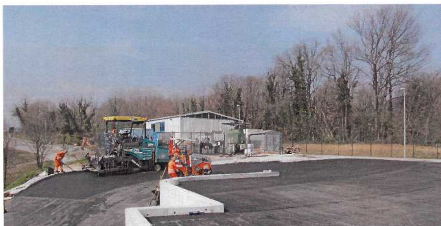
Slika: Izgradnja novega zbirnega centra ZC CERO Nova Gorica
