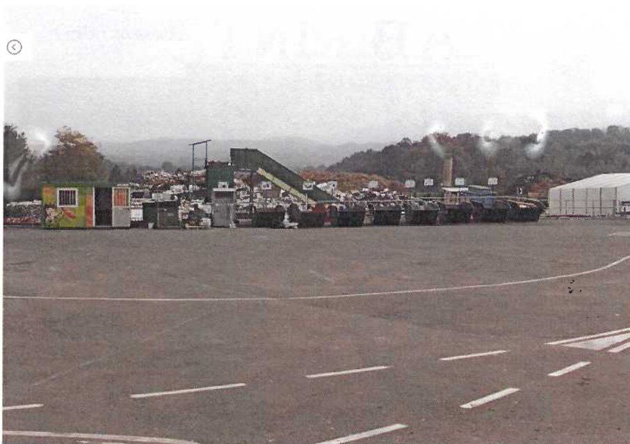
Slika: Zgrajen zbirni center CERO
