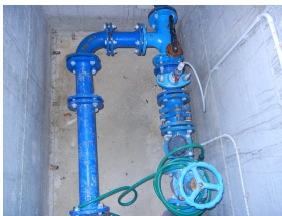
Slika 4: armaturna celica črpališča Plave
