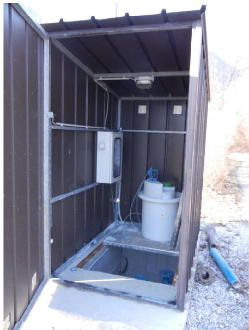
Slika3: objekt za pripravo pitne vode
