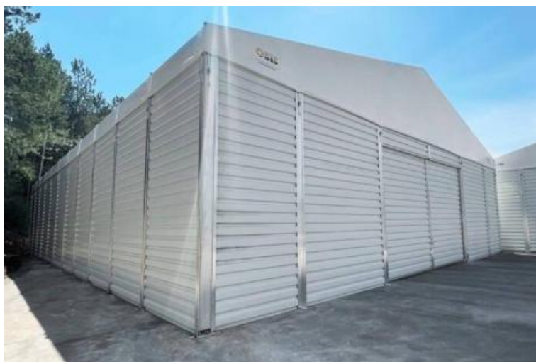
Slika 11: Prikaz montažnega objekta-prefabrikata (vir: investitor, marec 2026)
