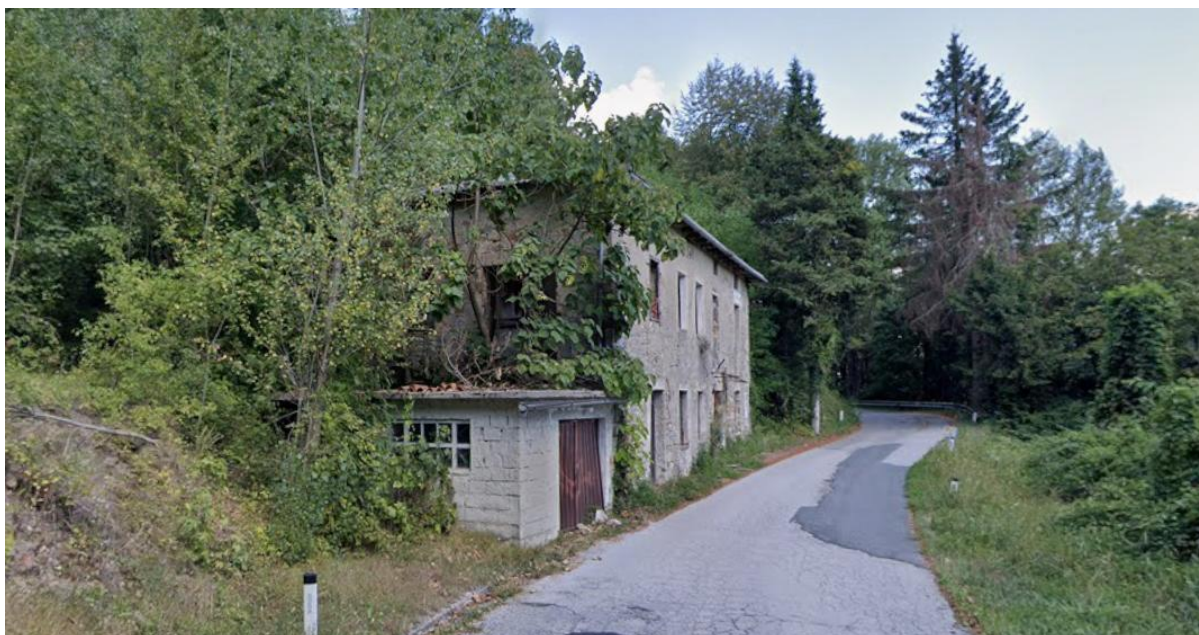
Slika 8: Pogled na obstoječi stanovanjski objekt, predviden za odstranitev
