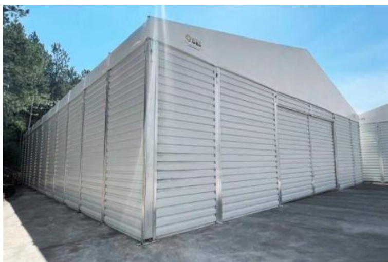
Slika 11: Prikaz montažnega objekta-prefabrikata (vir: investitor, marec 2026)
