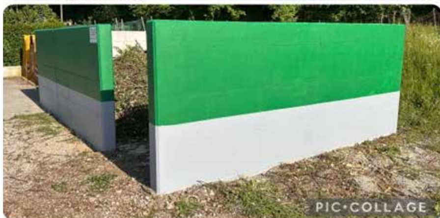
Prebarvan zid za zelene odpadke. Arhiv KS Deskle
