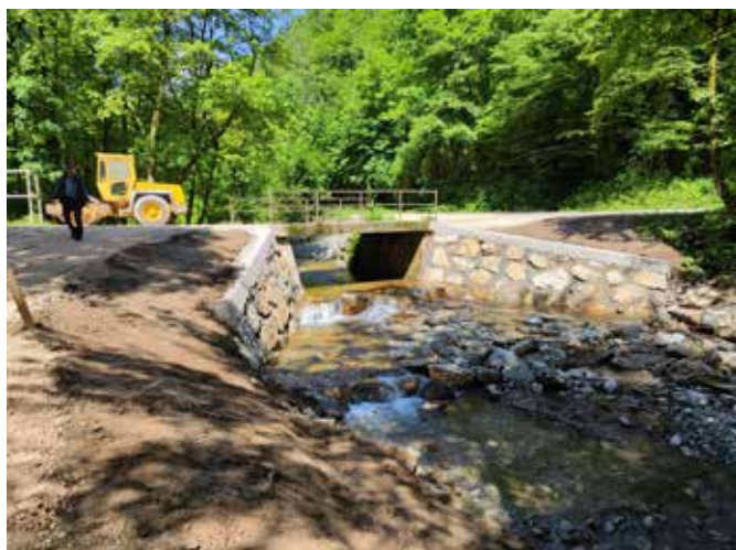
Sanacija obrežnega zavarovanja na mostičku v Doblarju
