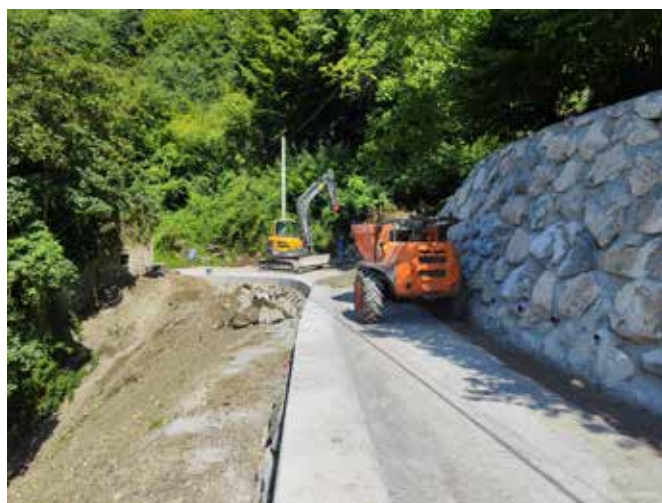
Sanacija podorov v vasi Bevčarji
