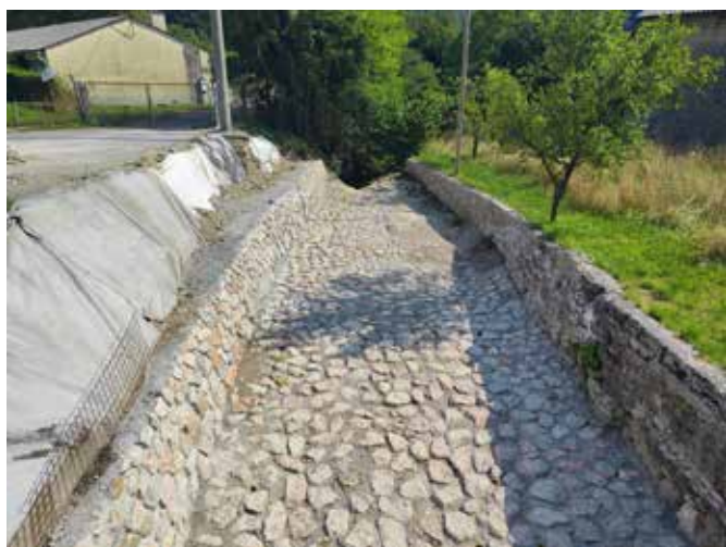
Sanacija brežine potoka Perivnik v Anhovem
