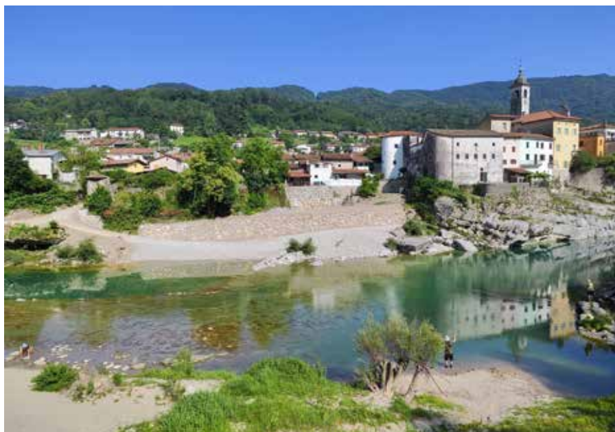
Obrežno zavarovanje v Kanalu
