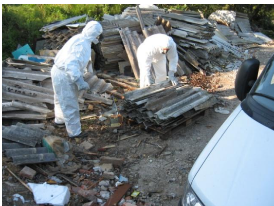
Slika: Sanacija divjega odlagališča azbestno cementnih odpadkov
