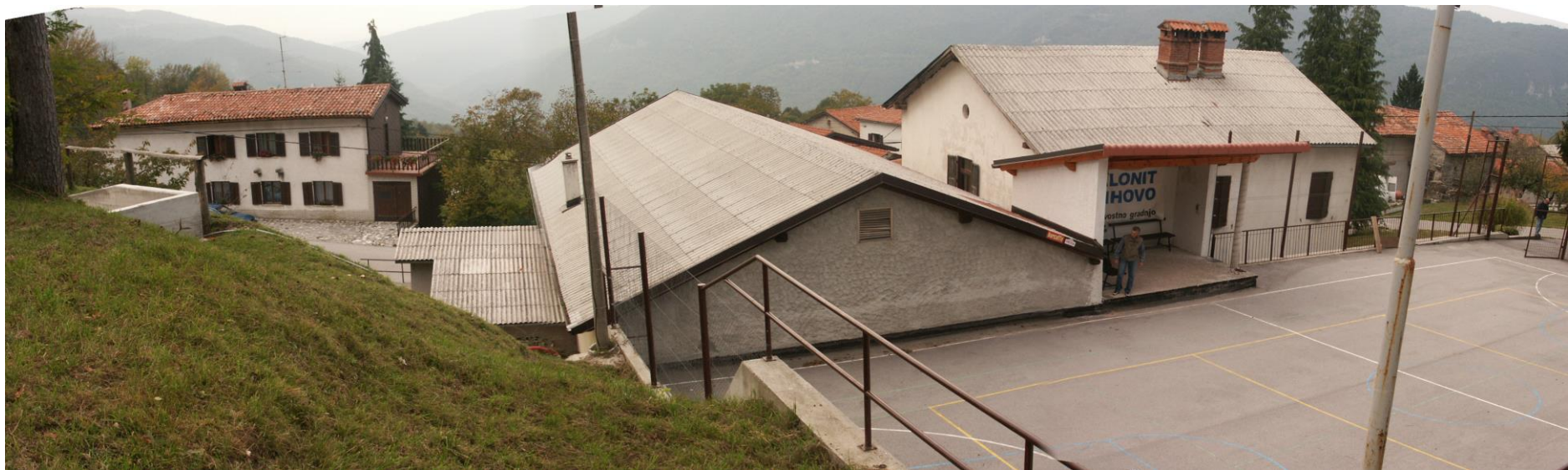
Pogled na obstoječi objekt iz brežine nad športnim igriščem (opomba: strešna kritina na glavnem delu objekta je bila v vmesnem času zamenjana s pločevinasto kritino Gerard)
