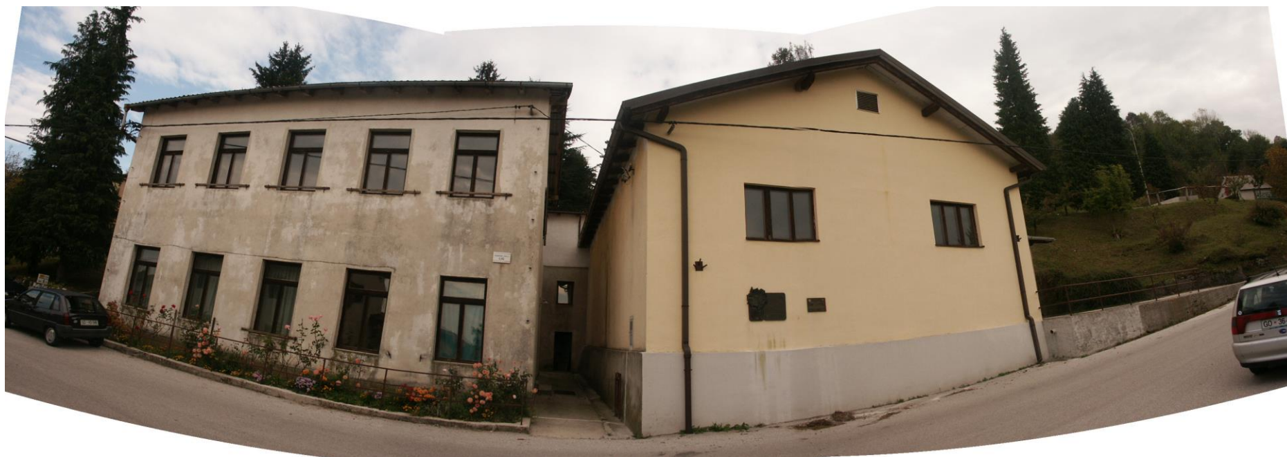
Pogled na obstoječi objekt iz glavne ceste; levo stavba nekdanje osnovne šole
