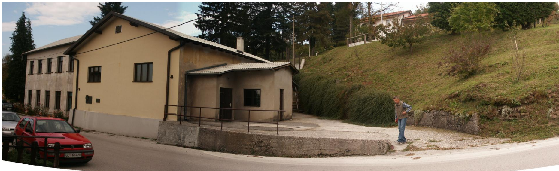
Pogled na obstoječi objekt in oporni zid (prekrit z zelenjem) iz državne ceste (opomba: strešna kritina na glavnem delu objekta je bila v vmesnem času zamenjana s pločevinasto kritino Gerard)
