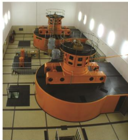
Po prenovi, ki se bo končala predvidoma v letu 2017, bo 76 let stara elektrarna delovala kot nova.
